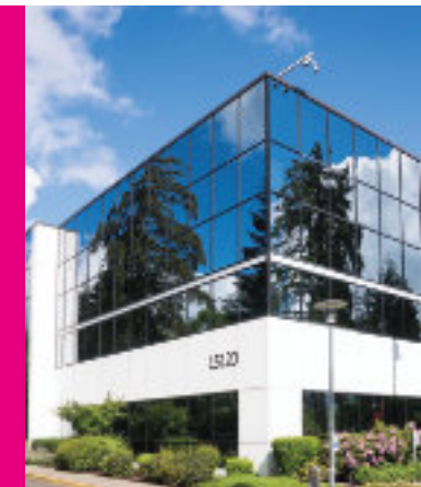
Figure 1. Méthode prescriptive La conformité selon une méthode prescriptive semble idéale. Suivre une liste de vérification est facile pour tout le monde. Cependant, l'atteinte de la norme de consommation énergétique nette zéro est problématique lorsqu'il faut tenir compte des ponts thermiques dans les grands bâtiments. Le calcul des ponts thermiques permet une plus grande flexibilité de conception, une réduction de l'utilisation des matériaux et une optimisation de l'enveloppe du bâtiment.
